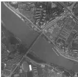
图 10 桥梁 1 原图 Fig. 10 Original Image of Bridge 1
