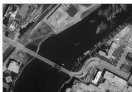
图 12 桥梁 2 原图 Fig. 12 Original Image of Bridge 2
