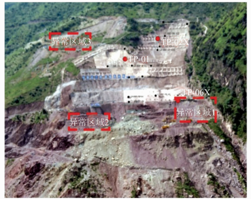
图9 开挖边坡实景图
